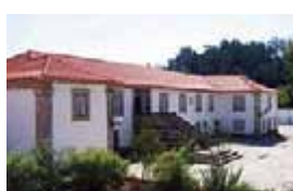
Cabeceiras de Basto Casa de Lamas
